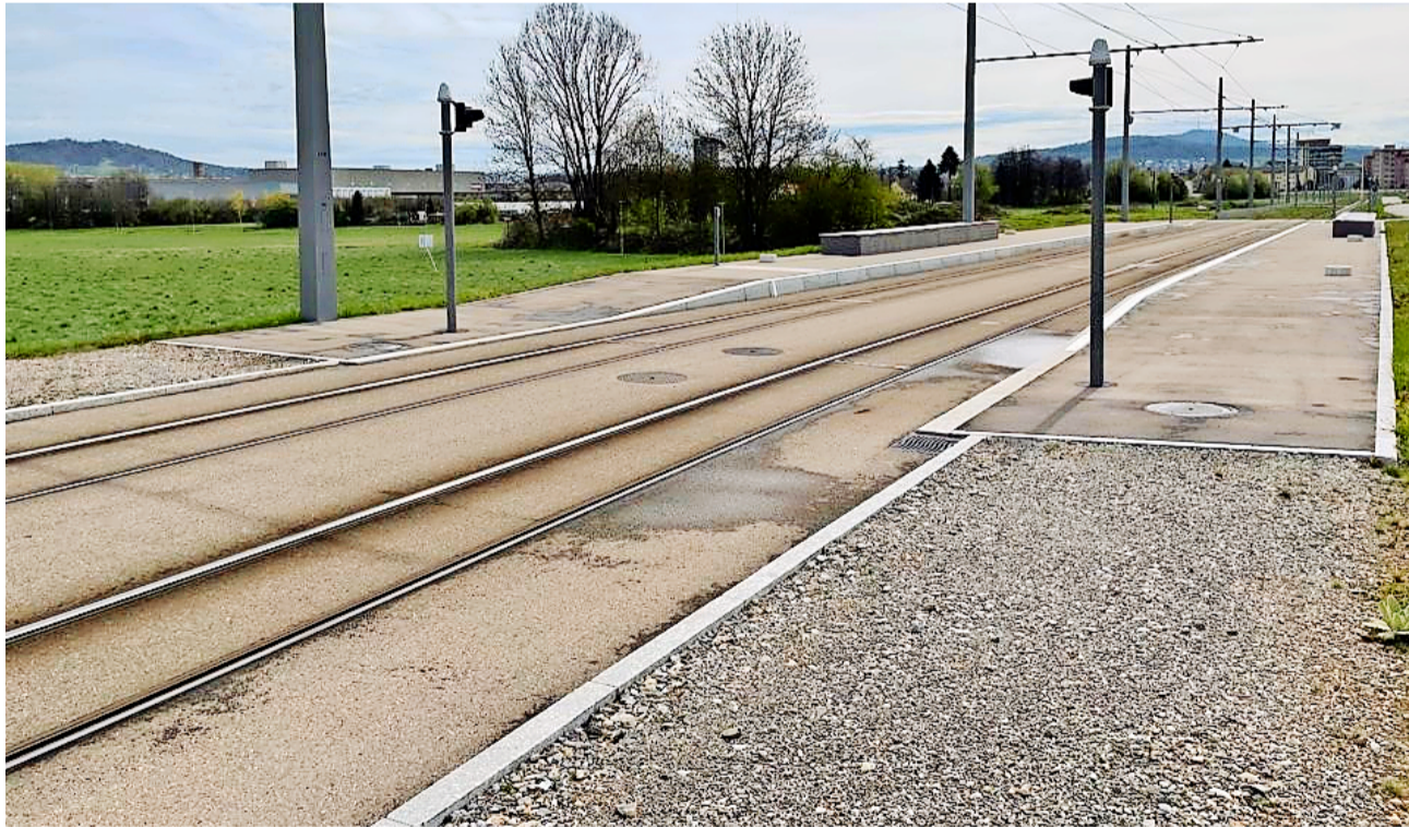
Bereits 1995 hat der Kantonsrat im kantonalen Richtplan das Niderfeld dem Zentrumsgebiet von kantonalen Bedeutung zugeteilt. Dieses bezeichnet Gebiete mit hoher ÖV-Erschliessungsqualität. Im Bild die Haltestelle Niderfeld.
