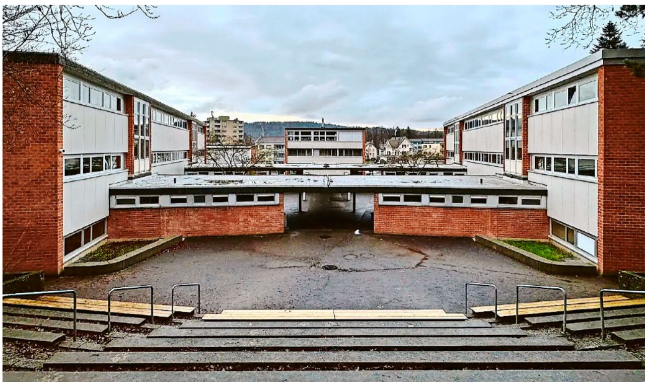
Das Schulhaus Wolfsmatt entspricht nicht mehr den heutigen Anforderungen.
