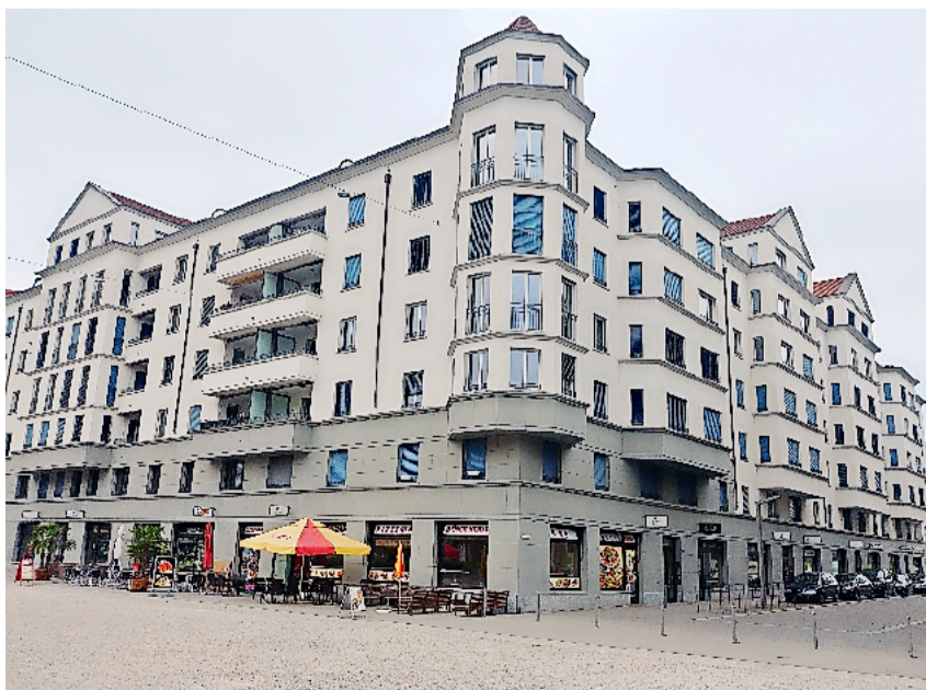
In Dietikon wird viel Modernes gebaut. Nach Meinung der Linken müsste es aber auch noch günstig sein. Im Bild: Wohnüberbauung Lindenhof.
