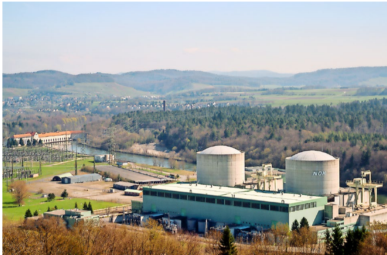
Längerfristig sind Kernkraftwerke für eine stabile Stromversorgung unverzichtbar. Im Bild: Kernkraftwerk Beznau.
