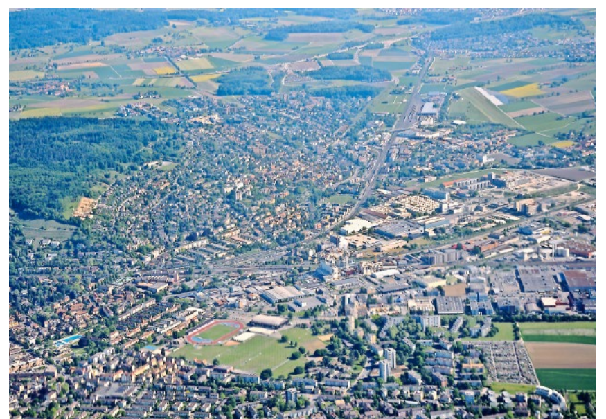
In Oberwinterthur steht seit 2021 ein grosses Rechenzentrum.
