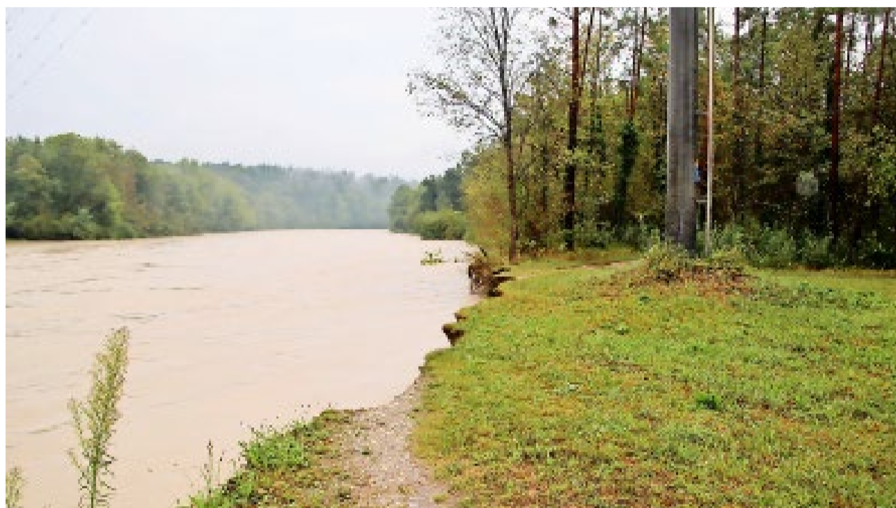
Wegen der Ufererosion steht der Hochspannungsmast nur noch knapp fünf Meter von der Uferböschung entfernt. Bild: ZVG
