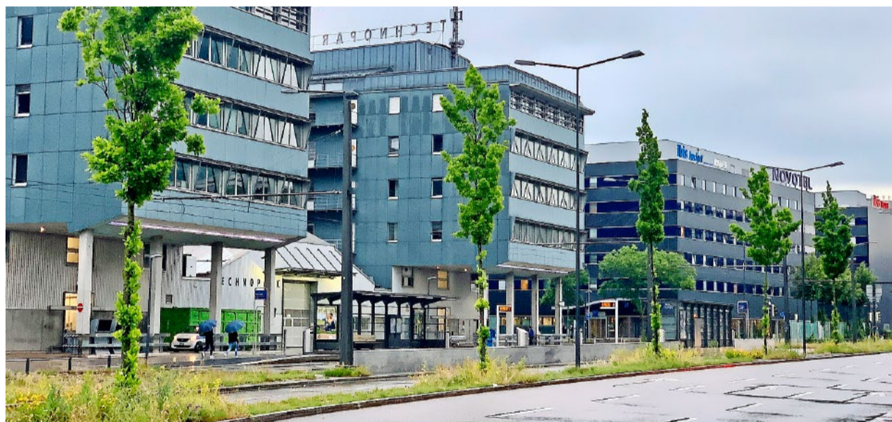
Der Technopark in Zürich beherbergt zahlreiche Start-Ups.
