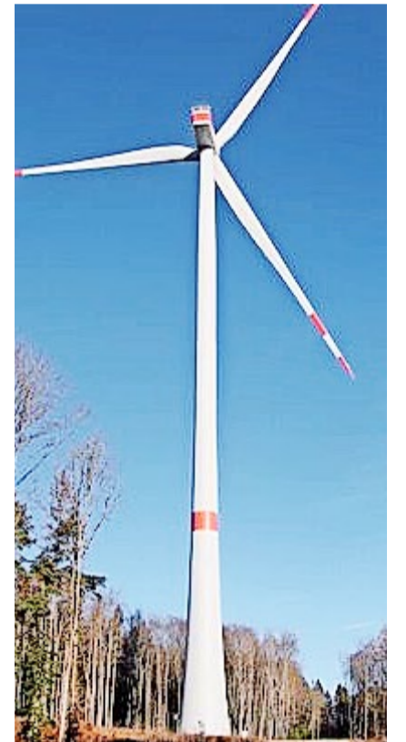
Windparks bleiben im Kanton Zürich umstritten.
