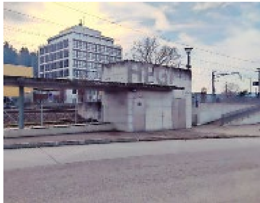
Busstation aus Sichtbeton.
