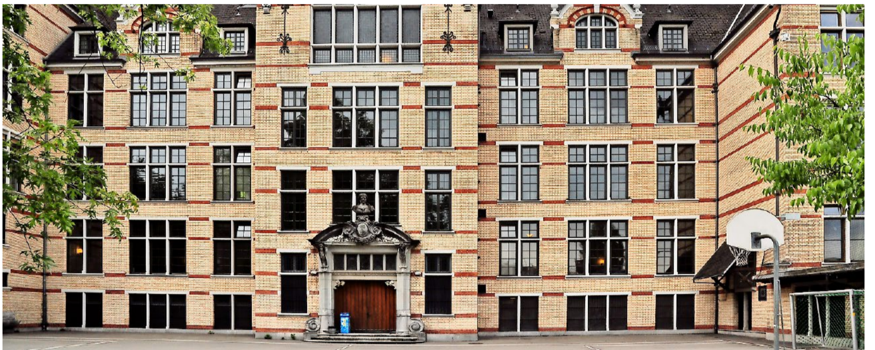
Beim Bau des Schulhauses Hirschengraben 1893 spielten die Kosten noch keine Rolle. Die Sekundarschule ist dekoriert mit Säulen, Mahagoniholz und barocker Aula.
