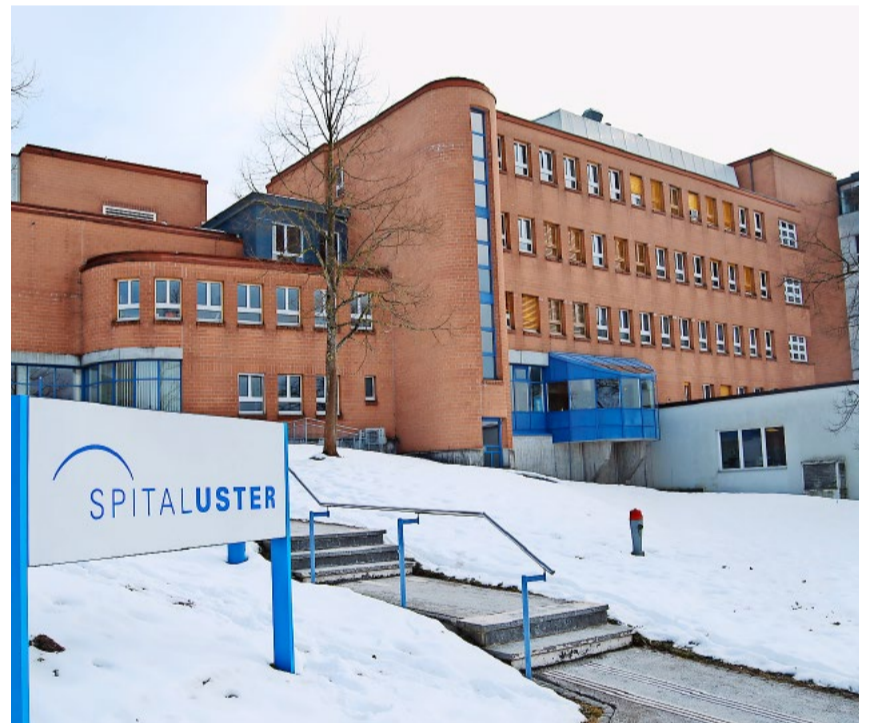
Viele Spitäler im Kanton Zürich haben finanzielle Probleme.
