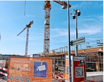
Die Bauarbeiten am neuen Werkhofareal in Effretikon können infolge wiederholter Diebstähle und Vandalenakte nur mit aufwendigen Überwachungsmassnahmen weitergeführt werden.
