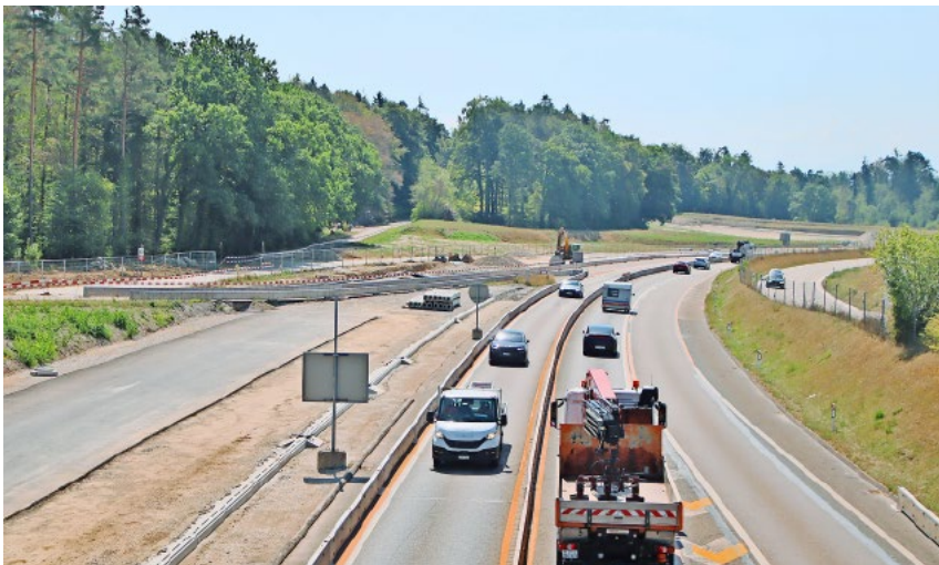
Bei Henggart erkennt man noch am linken Bildrand das alte Trasse der A4, welches jetzt als Radweg genutzt wird.
