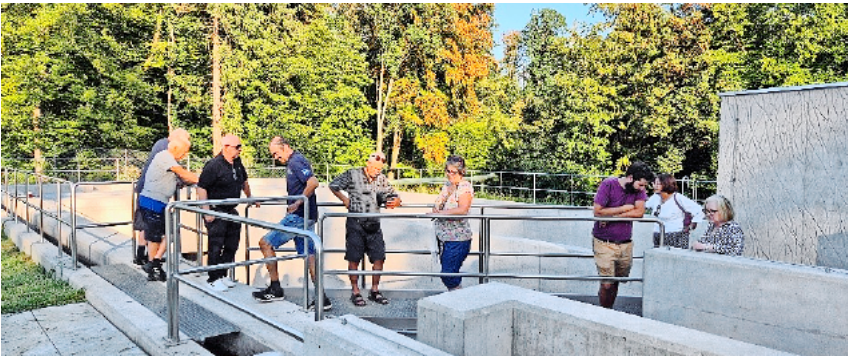
Eindruckliche Führung durch das Regenüberlaufbecken Aspholz in Esslingen. Bild: zVG
